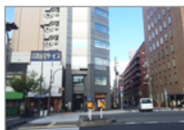
2 大手前M2ビル
