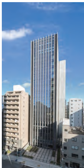
各事業所でLED照明への切り替え等、省エネへの取り組みを推進
